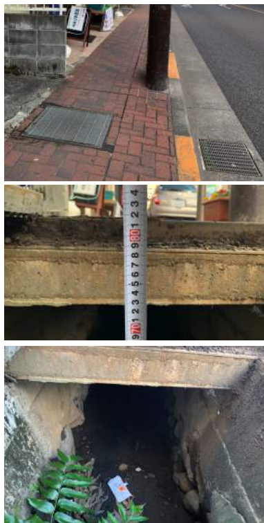
■青梅中央道線歩道水路現況写真
