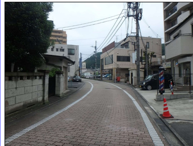
市道青2001号線 整備前(現況)
