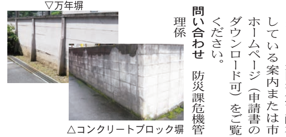
△コンクリートブロック塀
