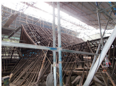
葺き替え工事の様子
