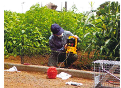
中型獣対策の電気柵設置の様子
