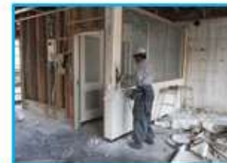
内装解体状況
