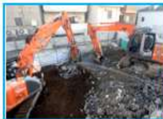
基礎解体状況
