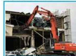
建屋解体状況
