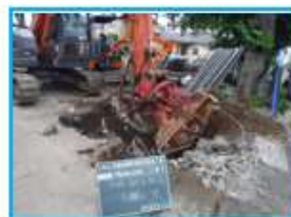
外構解体状況
