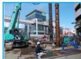
既存杭引抜き状況
