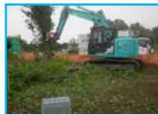
樹木・植栽撤去状況
