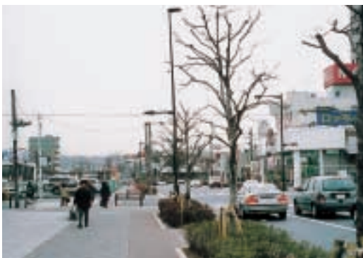
電線類の地中化・河辺北大通り
