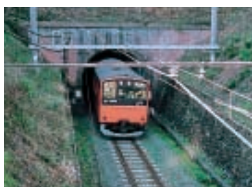
日向和田隧道（大正3年開通）
