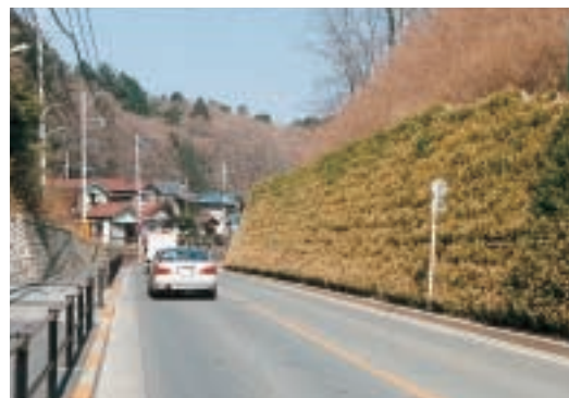
法面の緑化・天寧寺坂通り
