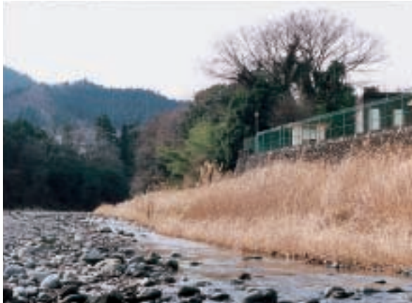
日向和田上水道取水場（昭和2年完成）
