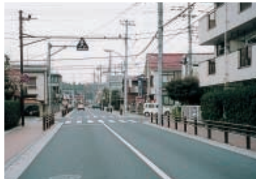
歩道の整備・城前東通り
