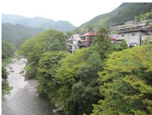
川沿いの崖上に近接して立地する建物
