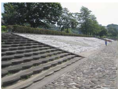
コンクリートの長大な修景階段護岸（市民球技場前）。
