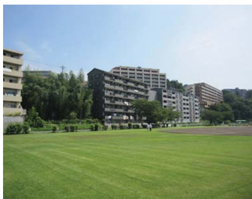
川に直接面するマンション
