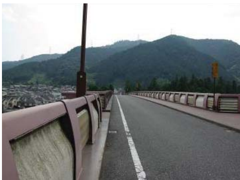
川に対して遮蔽的な印象の高欄。 (奥多摩橋)
