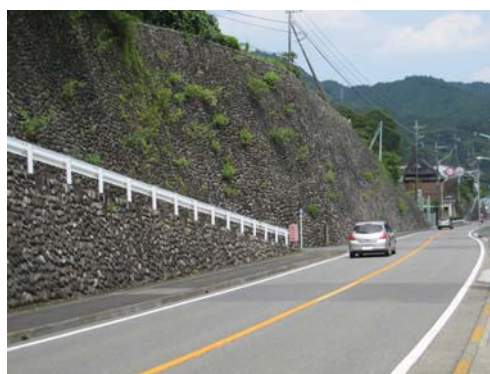
自然石の道路擁壁
