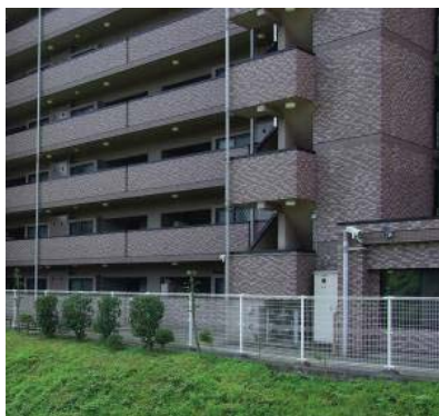
右岸側の建物では橋から眺められる北側の壁面が日照の関係から裏側になりやすく、配管などの設備類が目立ちやすくなる傾向がある。
