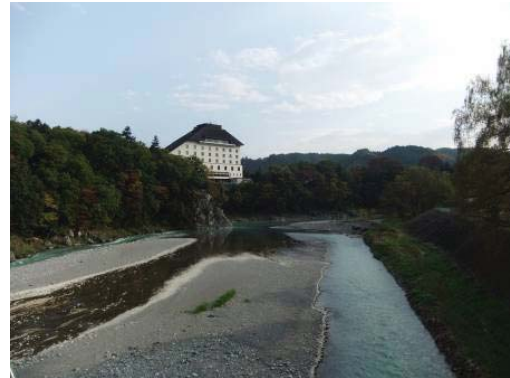
白色系の大規模な壁面は周辺から浮き上がりやすい。
