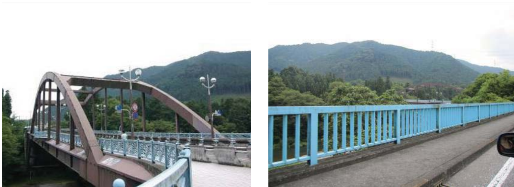
周囲の景観になじまない橋梁の高欄。(軍畑大橋 (左)、鎧橋 (右))
