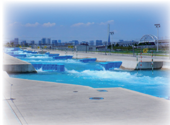
△カヌースラロームセンター
