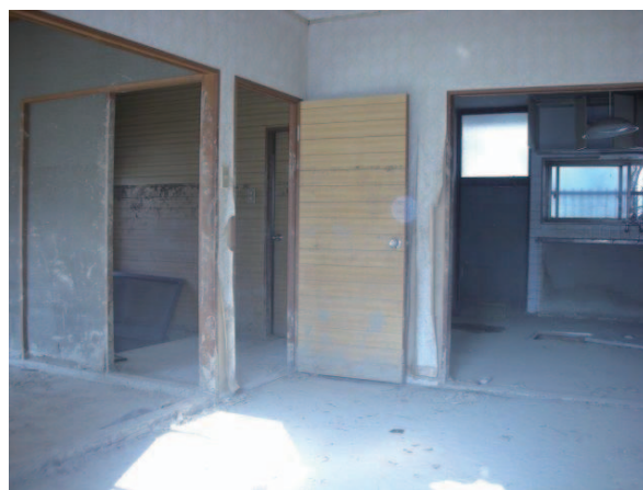
(写真左)土石流をせき止めてしまった線路の盛土…唯一の水が抜けるトンネルはがれきでふさがってしまった (写真右)呉市天応地区の土石流被害を受けた住宅の内部…ドアと左奥の部屋に水位がわかる跡が残っている
