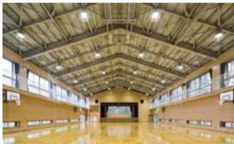
LED化が完了した第四小学校の体育館
