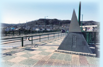
現在の多摩川橋
