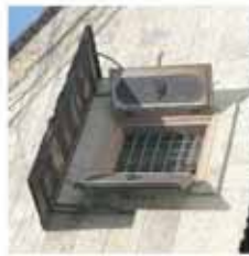
2階開口部の高気密障（観音障）
