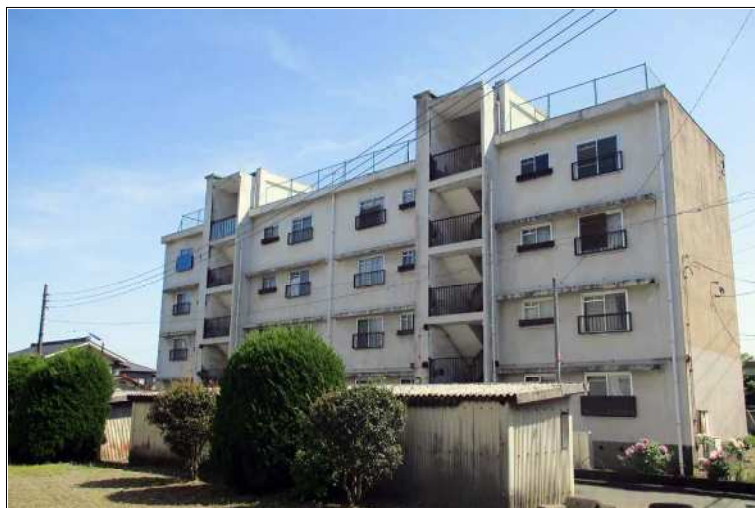
市営住宅(千ヶ瀬第3)
