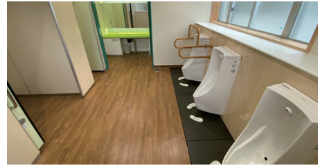
令和元年度に改修した四小のトイレ
